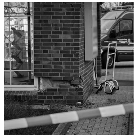
Die Fassade des Gebäudes nach Entfernung des PKW
